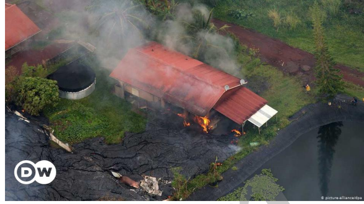
Binalara zarar veren lav akıntısı
