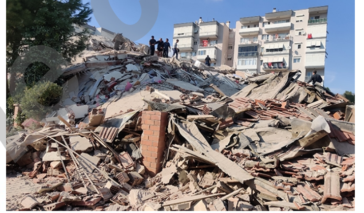
Depremler sonucu yıkılan binalar
