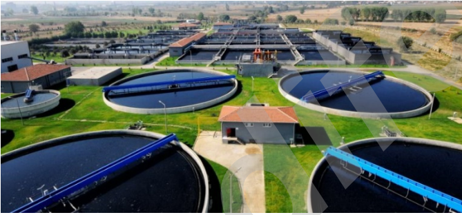
Atık su arıtma tesisi
