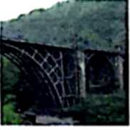
Köprülerde kullanılan demir
